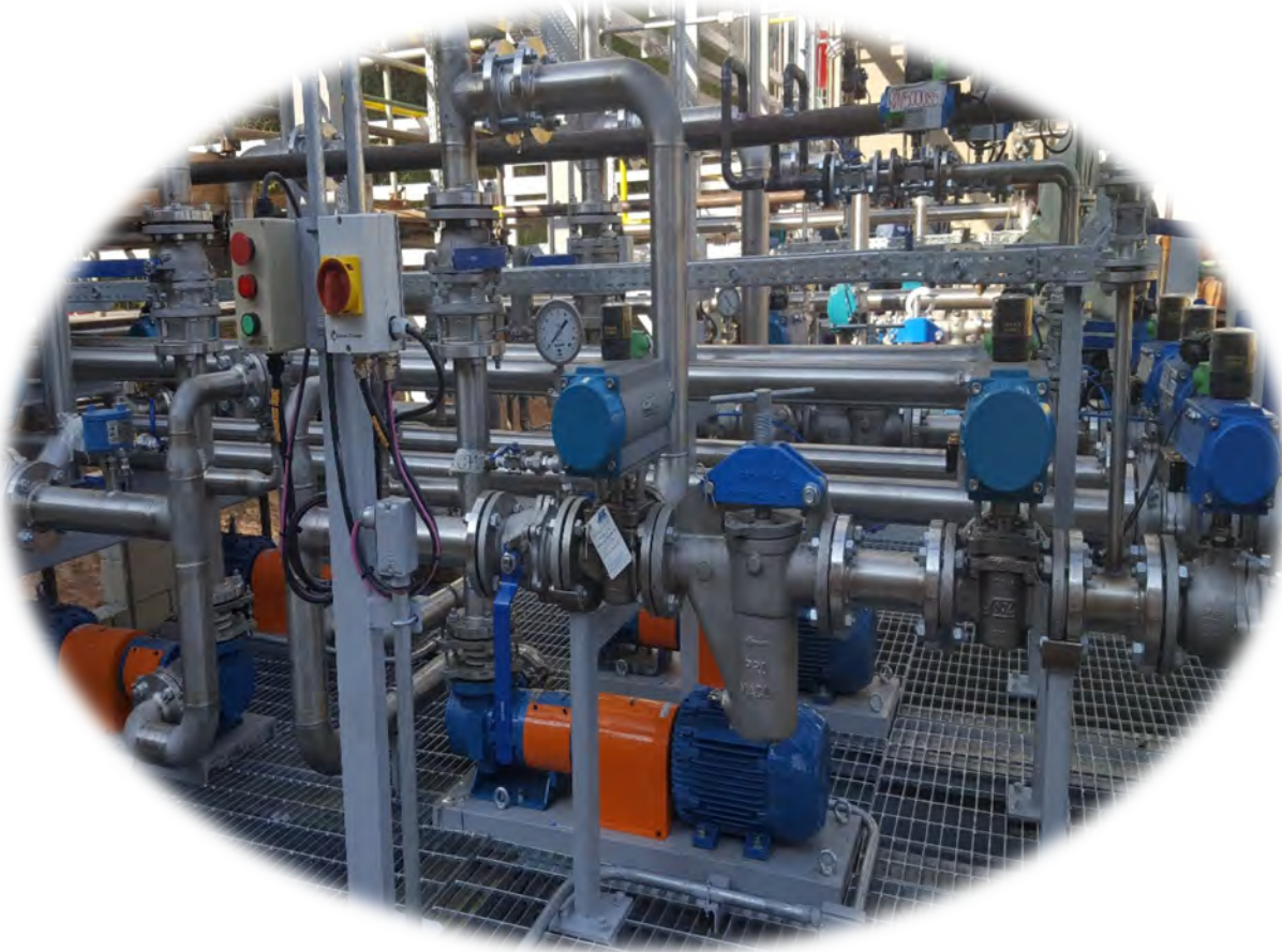
Descarregamento de Químicos - CRODA
