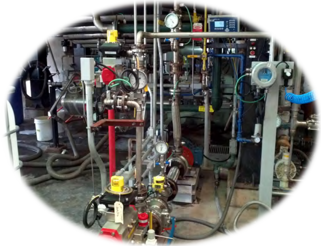
Descarregamento de Metil Acrilato com Air Barrier – Rhodia Solvay
